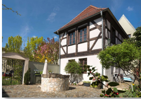
Hof mit Fachwerkanbau
